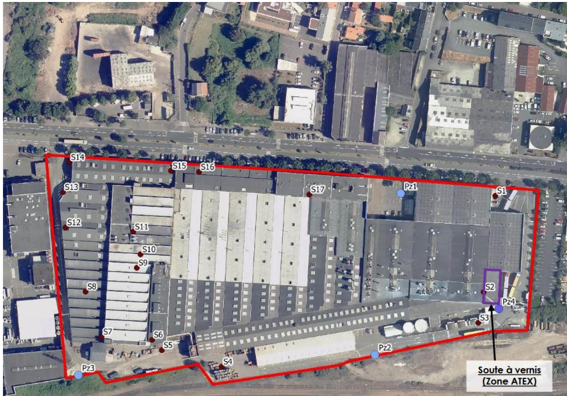
Figure 4 - Localisation des piézomètres Pz1, Pz2, Pz3 et Pz4 (soute à vernis S2)
